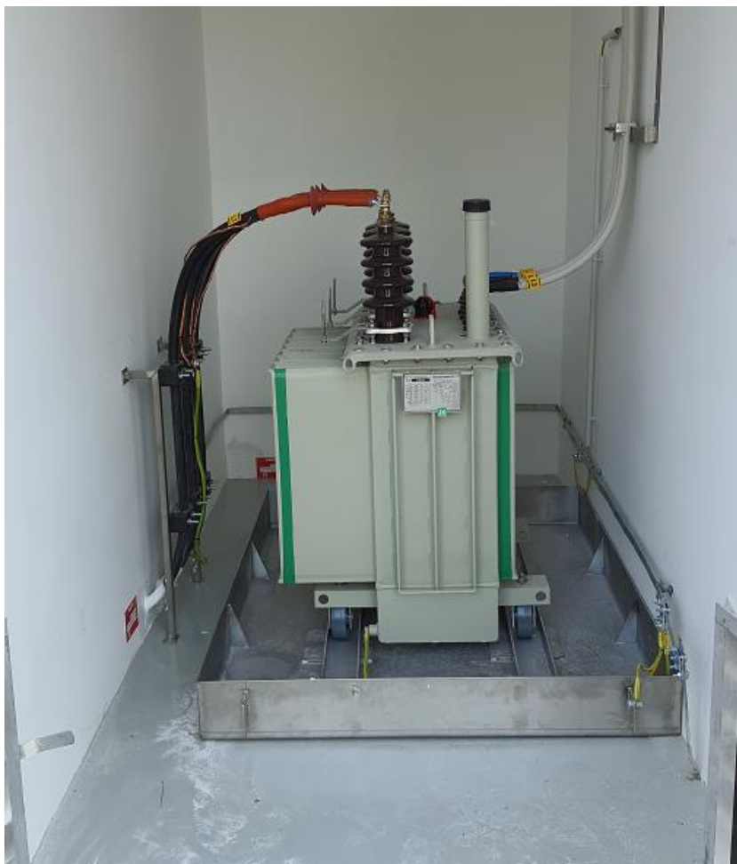
Slika 4-4: Primer vgradnje in montaže TR
